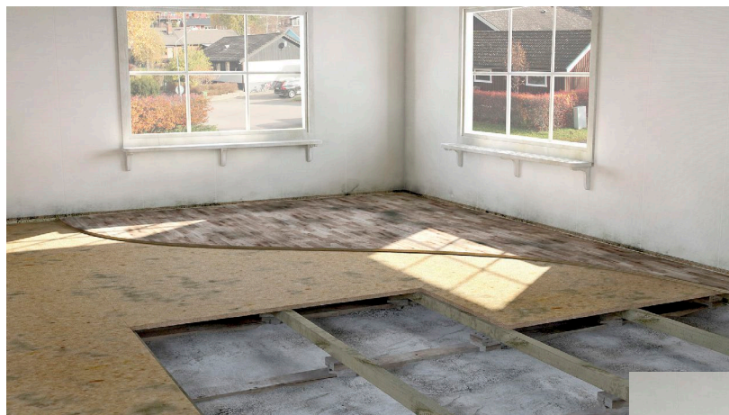
2. Betongplaten rengjøres for alt organisk materiale.
