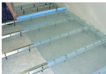
22 mm lastulevyn asennus uivana
