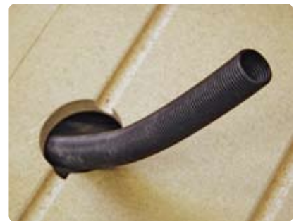
Golvvärmerören dras via skyddsror till respektive rum med golvvärme
