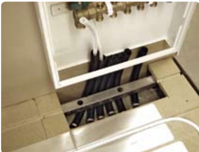
Skyddsroren innehållande golvvärmerören dras upp och ansluts vid golvvärmefördelaren
