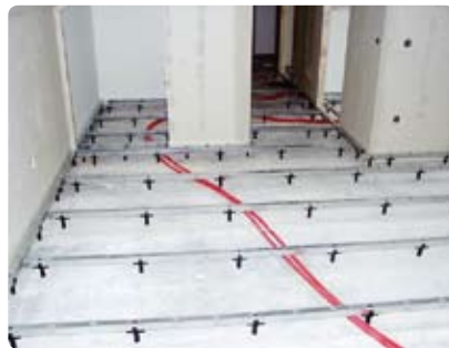
El- och rörledningar dras flexibelt under det färdiga golvet
