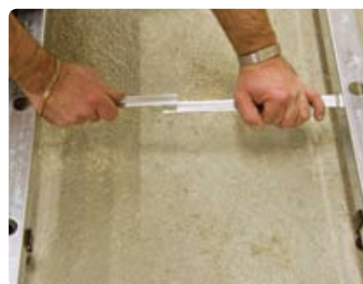
Vid mindre regelfack kapas fästplåtar och golvvärmekassetter för att passa in
