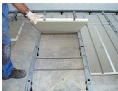
Golvvärmekassetterna läggs ovanpå fästplåtarna
