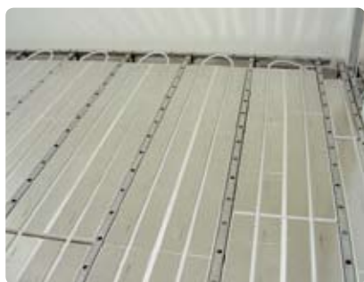
Ett färdigt golvvärmesystem provtrycks innan ytskiktet monteras
